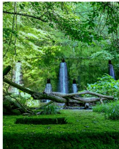
momo2007_2022様 秋田県 金山砂防ダム
