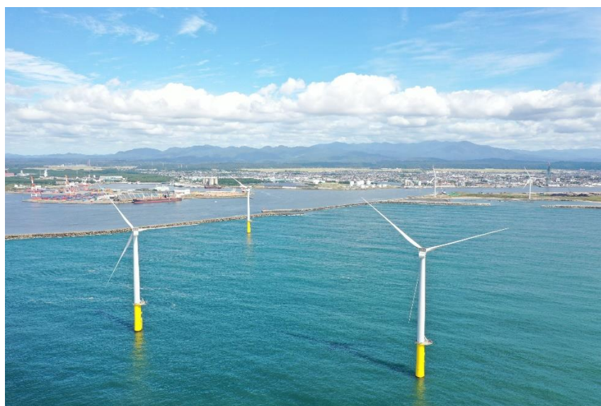
秋田港洋上風力発電所（提供：秋田洋上風力発電株式会社）
