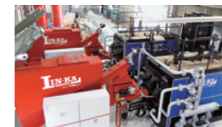
大潟村に整備されたもみ殻バイオマス熱供給施設
