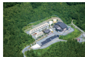
上の岱地熱発電所（東北電力㈱提供）
