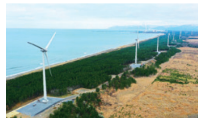
新能代風力発電所（東北自然エネルギー㈱提供）
