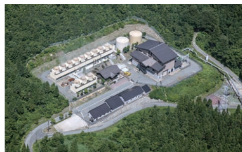
上の岱地熱発電所(東北電力㈱提供資料)
