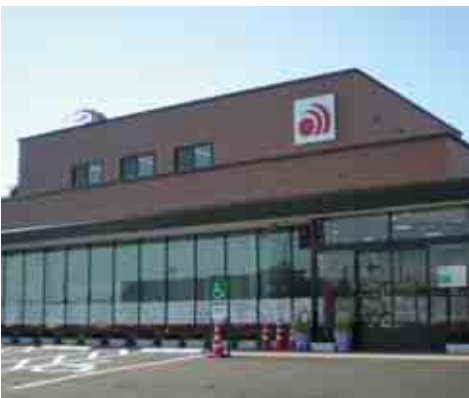
御所野ニュータウン支店外観
