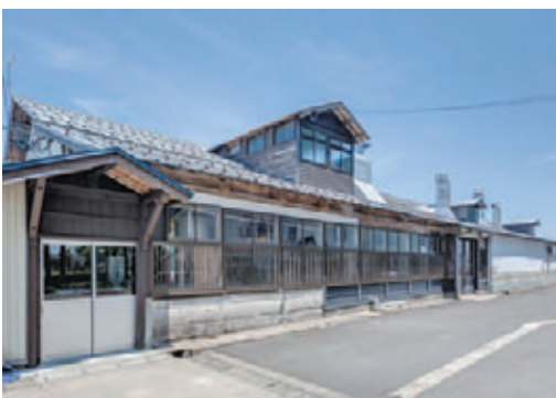
社屋外観。昔ながらの木造の建物内には、酒蔵当時の設備が現在も残っており、乳酸菌の培養に使われている。
