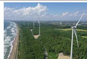
A-WINDかたがみ風力発電所
