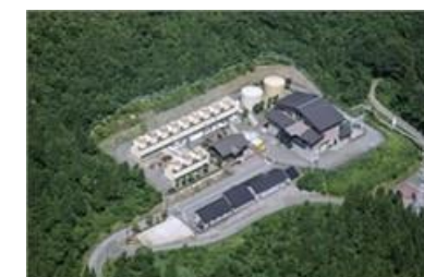
同支店に電力の供給を行う上の岱地熱発電所提供：東北電力株式会社
