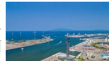
秋田洋上風力発電の 洋上風力発電所完成イメージ
