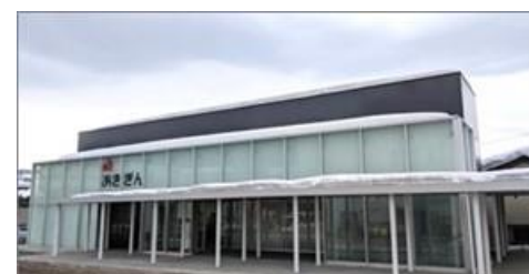
湯沢支店の外観
