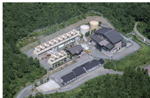
上の岱地熱発電所(東北電力㈱提供資料)
