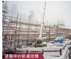
建築中の新湯治棟
